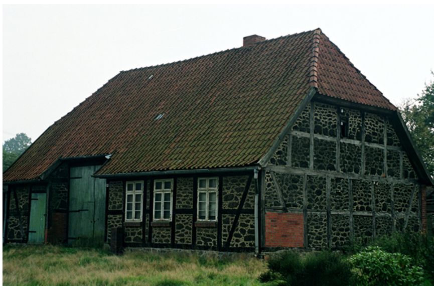
Ябельхайде. Глайзин. Дом безземельного крестьянина-хойслера с поперечным диле. Строительный материал – «клумп».
